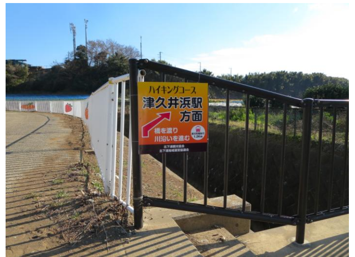
H : 津久井耕地整理地区南側橋
