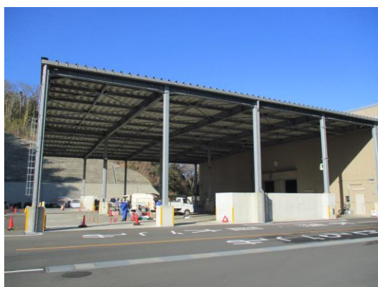
前処理ヤード
