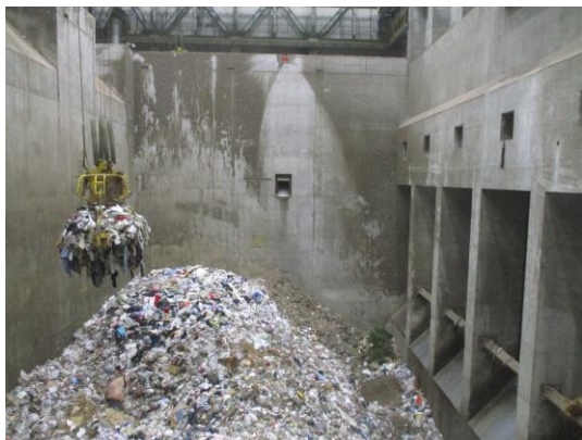
燃せるごみピット内の様子
