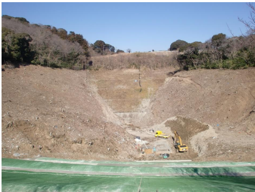
施工前(平成27年2月撮影)
