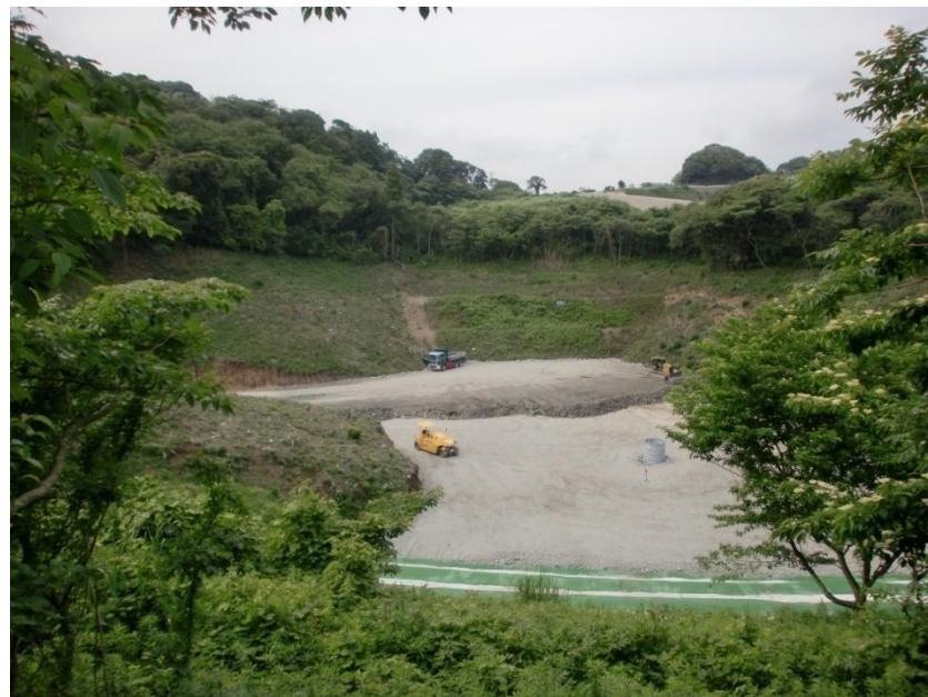
施工後(平成27年6月撮影)
