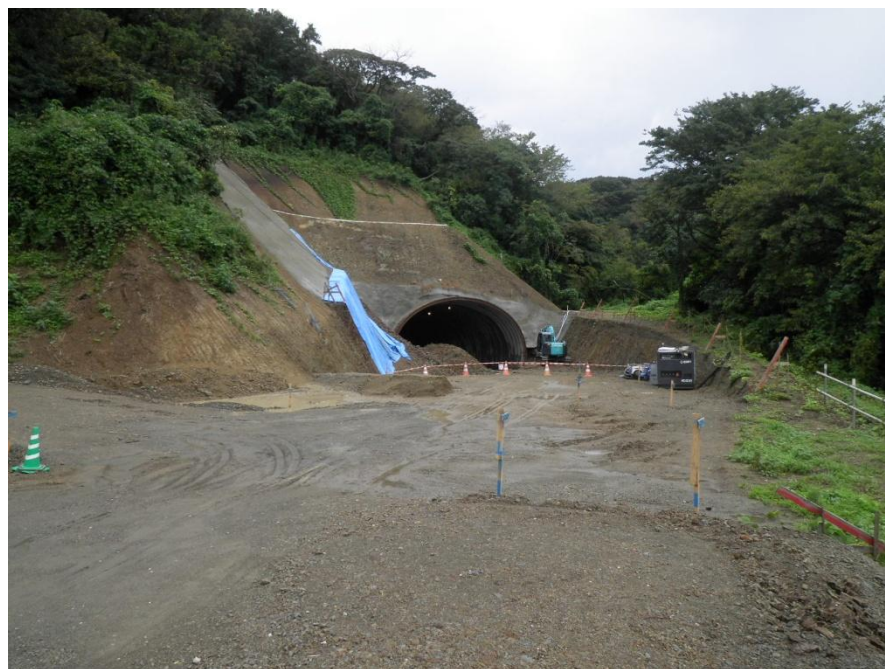
施設建設予定地側(平成27年9月撮影)
