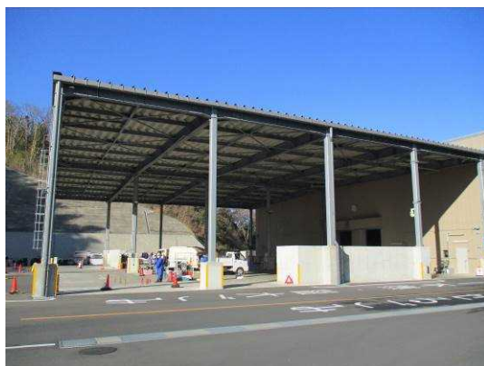
前処理ヤード
