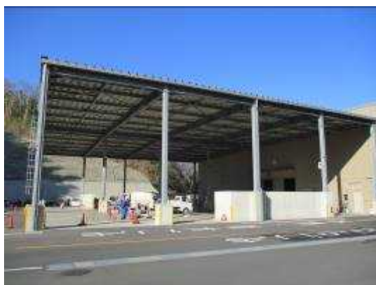
前処理ヤード
