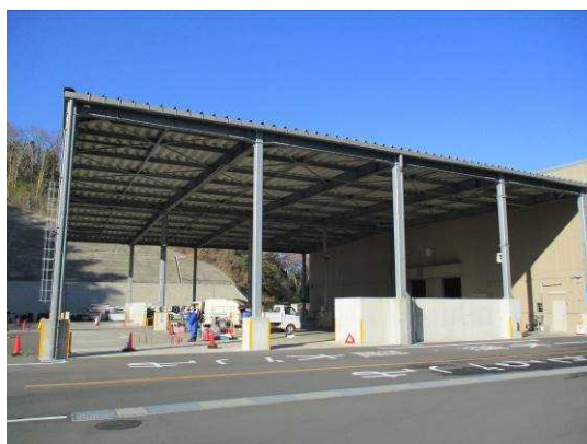
前処理ヤード
