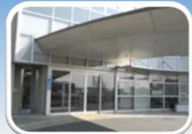
横浜市駒岡地区 センター
