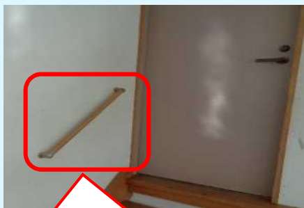
設置した手すり 安全性を確保
