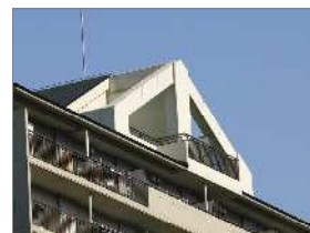
塔屋の部分にフレームを使って、屋根形状に工夫がされています。（横須賀市）
