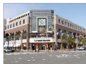
地域の特徴である赤レンガをイメージしたレンガタイルや、洋風近代建築らしい意匠を工夫しています。（横浜市）
