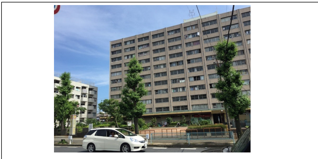
図表 2 A棟（南側の市道から）
