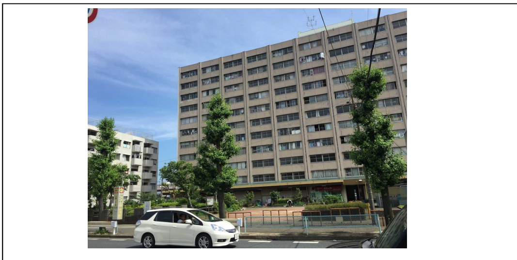
図表 2 A棟（南側の市道から）
