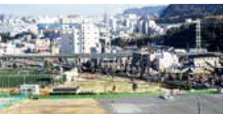
整備工事を行っている佐原2丁目公園野球場
