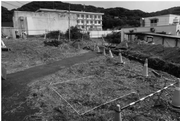
写真1 試掘坑TP1 全景
