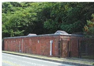
市内唯一の水源、走水水源地
