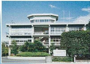
●下町浄化センター
