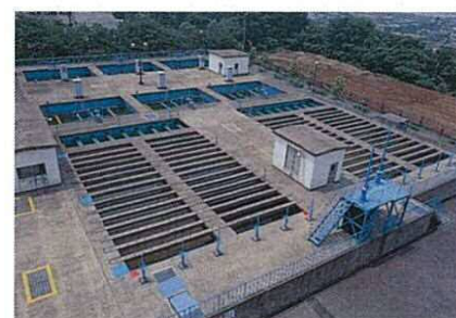
傾斜板沈でん池
