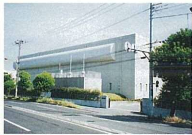
●9 舟倉第2ポンプ場
