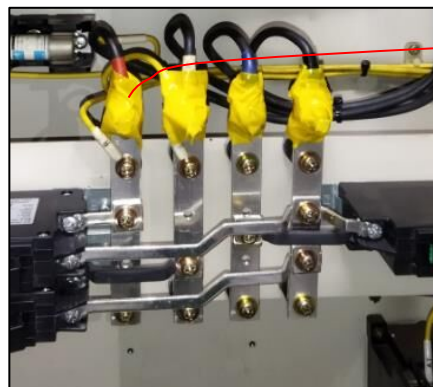
端子間距離が近い分電盤についての絶縁テープ処理の様子
