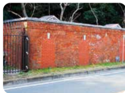
走水水源地「れんが」煉瓦造貯水池
