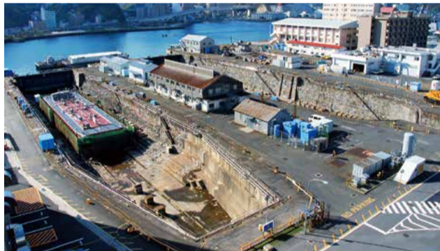
明治初期に起工したドライドック。現在は米海軍基地内にて現役で使用。
