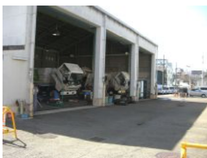
自動車整備工場の外観
