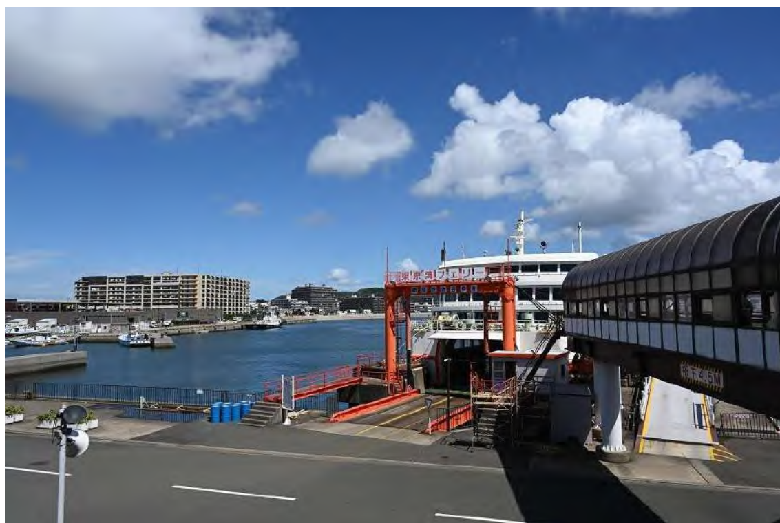
▲③港の活用推進（久里浜港）
