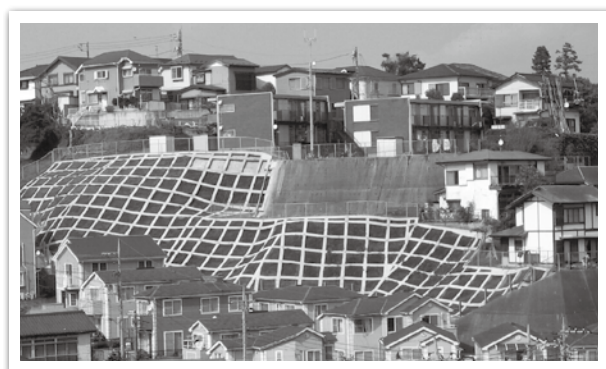
急傾斜地崩壊防止工事
