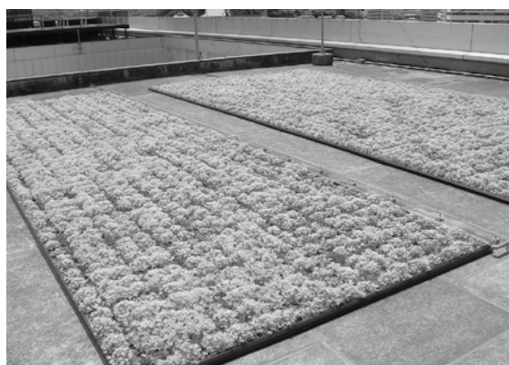
公共施設の屋上緑化
