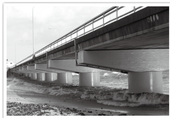
橋りょうの耐震補強
