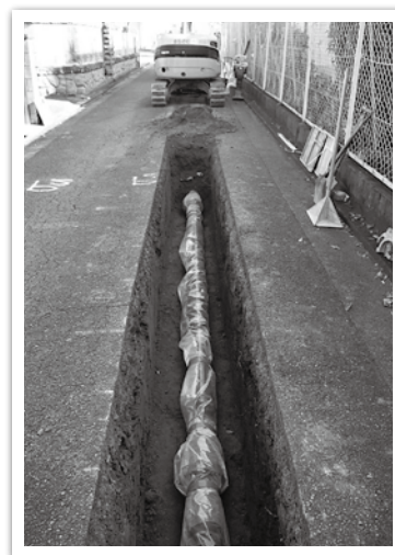
配水管の布設替え
