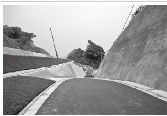
防災道路の整備
