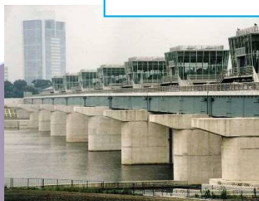
水を取る 取水施設
