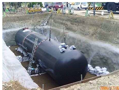
非常用貯水装置の設置
