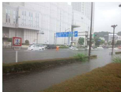
道路冠水（国道16号）
