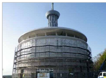
湘南国際村配水池の外壁修理
