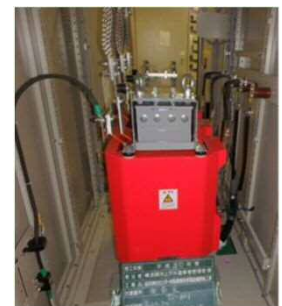
高効率機器への交換事例（変圧器の更新）
