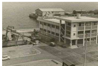
日の出ポンプ場 (昭和41年(1966年)建設)
