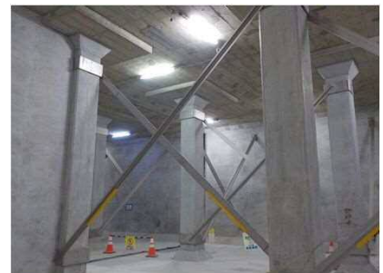
配水池耐震化工事 (小雀配水池)
