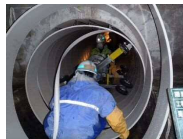
更生工法※31による改良
