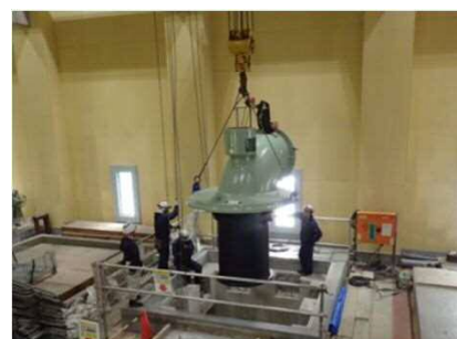
ポンプ設備の更新
