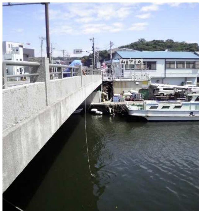
図 4-21 公共用水域の水質測定の様子 (夫婦橋)
