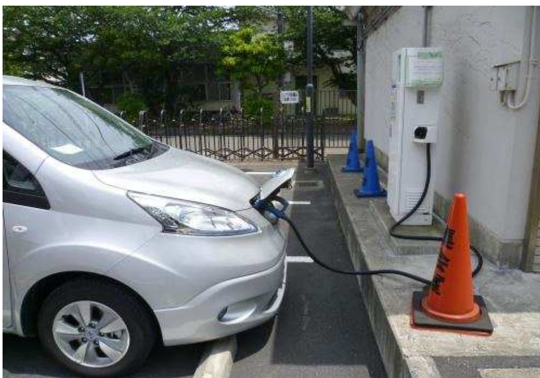
図 4-14 給電中の電気自動車の様子
