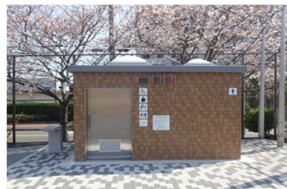
神明第2公園（トイレ、園路整備）
