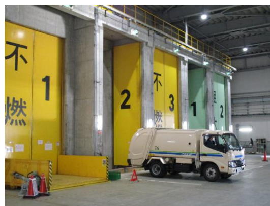
不燃ごみ等の投入ステージ
