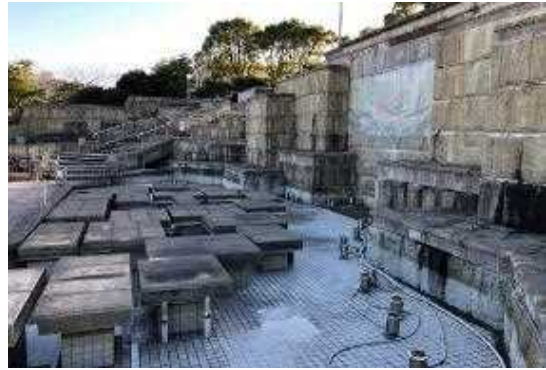
② 現状利用されていない壁泉
