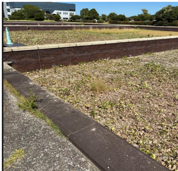
（半原水源地からつながる緩速ろ過池の跡地）
