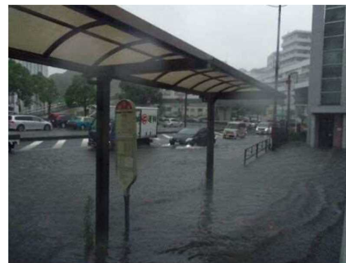
国道16号 本町3丁目付近の浸水状況 (令和3年7月3日)
