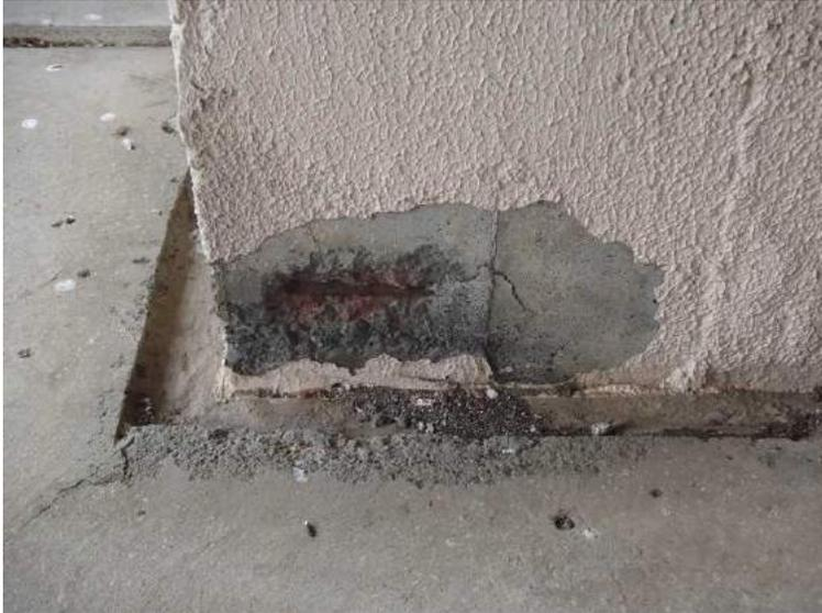
■柱内の鉄筋が錆びて膨らむことによりコンクリートを破壊する現象を「爆裂現象」と言い、鉄筋コンクリートの老朽化を表します。
