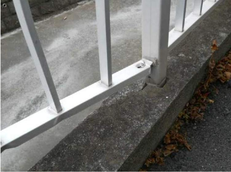
■基礎コンクリート部分の破損、腐食などにも注意が必要です。
