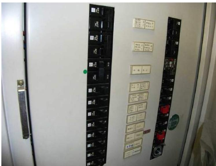
■分電盤はコンセントや照明などに電気を分配する装置で、使い過ぎや漏電による事故を防ぐ役目もあります。
