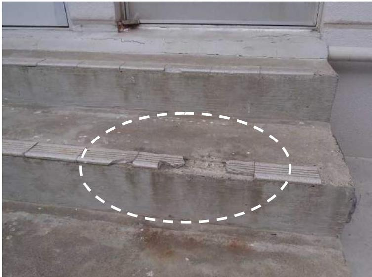
■タイル・コンクリートの場合はひび割れ、鉄骨の場合は錆と腐食に注意が必要です。
