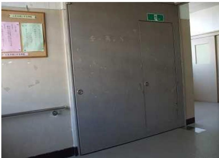
■防火戸は火災の延焼・拡大を防ぐために、建物内部の開口部に設置されています。
