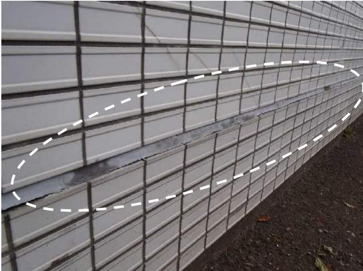
■目地（タイルの継ぎ目）に亀裂などがあると、そこから雨水が侵入し、建物の躯体自体や設備の劣化などにつながります。
