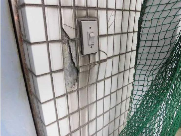
■屋外用コンセントが破損して雨水が器具内に侵入すると漏電の恐れがあります。
