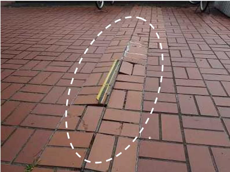
■アスファルトや地面にひび割れ、陥没、段差があると歩行者がつまずいたり、転倒する危険性があります。
