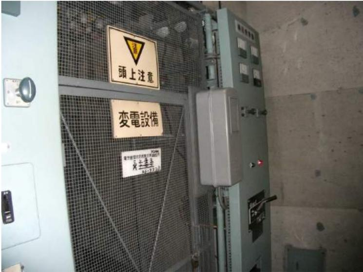
■受変電設備は送られてくる6,600ボルトの高圧電気を100ボルトに変圧して施設のコンセントに電気を供給しています。
