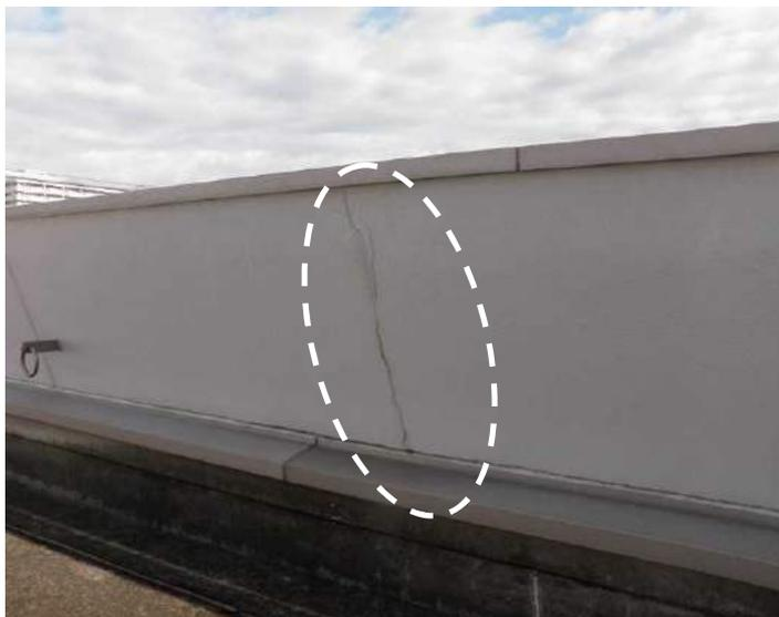
■パラペットに亀裂、損傷があると、そこからコンクリート片等が剥落する危険性があります。
