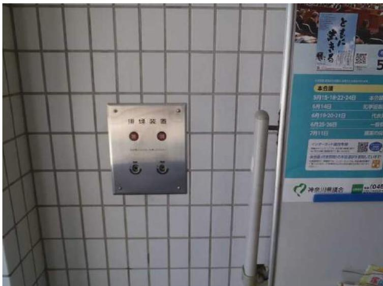
■排煙窓は火災で発生する煙や熱を外部に排出させる役割があり、ボタンやハンドルで操作します。
