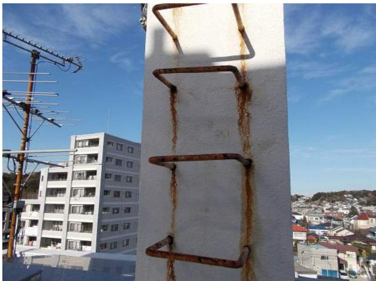
■タラップの接合部分やフェンス支柱の根本部分の基礎コンクリートのひび割れ、損傷にも注意が必要です。
