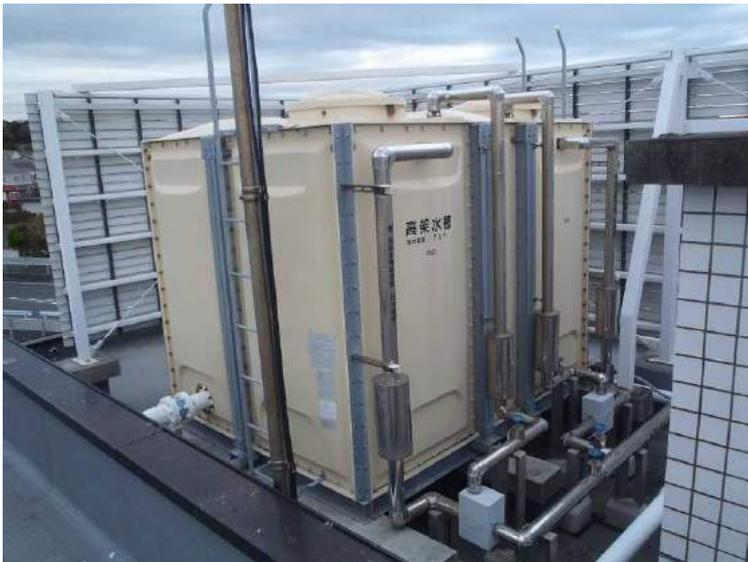
■受水槽・高架水槽は、建物内に供給する水を一旦溜めておくタンクで、災害時の給水支援にも役立つ設備です。
