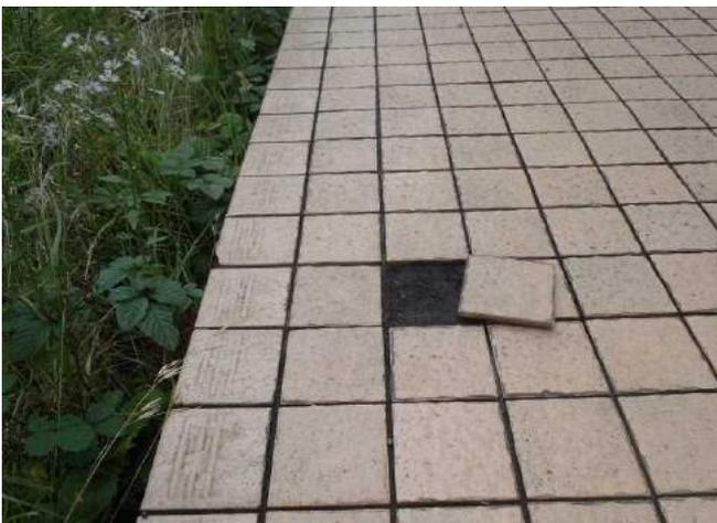
■大きな木の根が地面を押し上げてひび割れ、段差などが生じているケースもあります。
