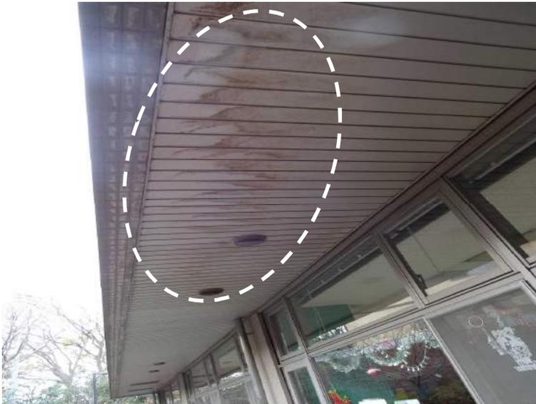
■軒裏の天井材に雨水による膨れや錆汁跡が見られる場合には、天井材が腐食し脱落に至るおそれがあります。
