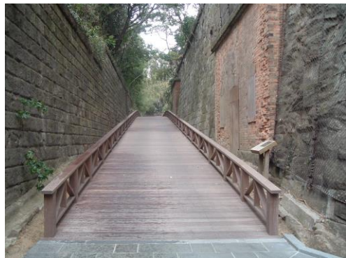
猿島の園路（ブラフ積擁壁と坂道）
