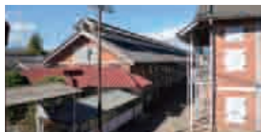
現在の富岡製糸場の建物 (写真提供：富岡市・富岡製糸場)
