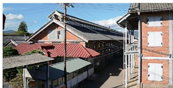
現在の富岡製糸場の建物 （写真提供：富岡市・富岡製糸場）
