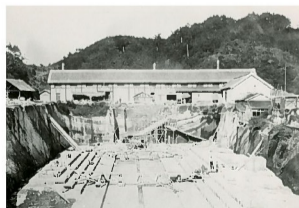
建設中の1号ドック
