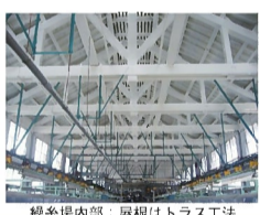
製糸場内部：屋根はトラス工法
