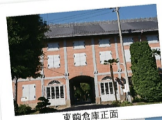
東館倉庫正面
