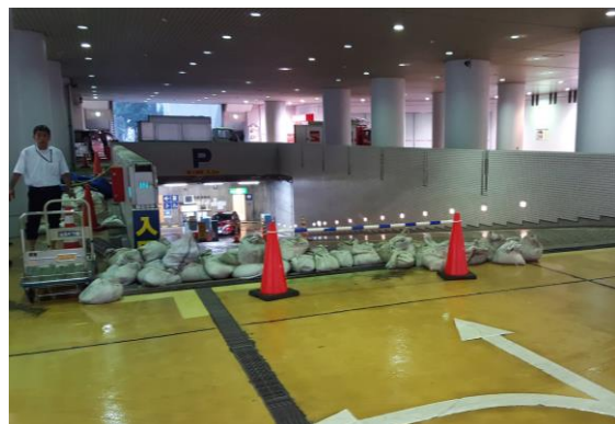
台風時の雨水侵入防止対策
