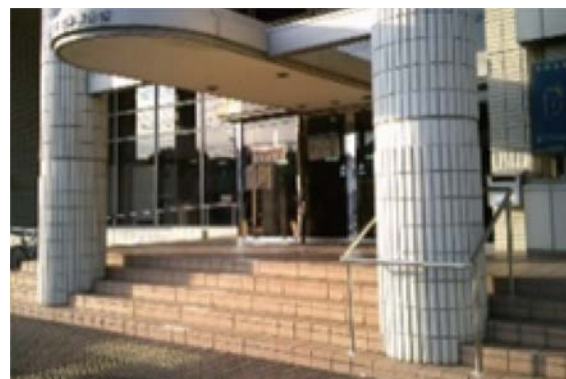
〈北体育会館手摺設置〉
