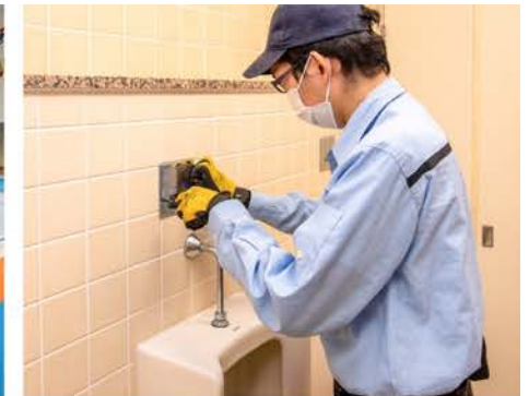
〈水洗トイレのバルブ調整〉
