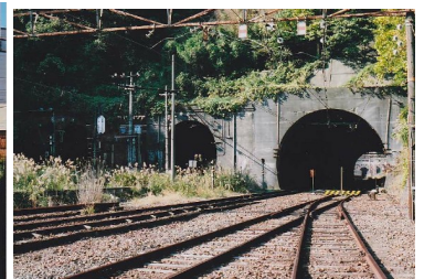
JR田浦駅七釜トンネルから長浦側
