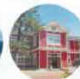
旧長井小学校 第一校舎
