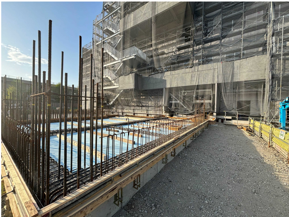
リニアック棟 施工状況
