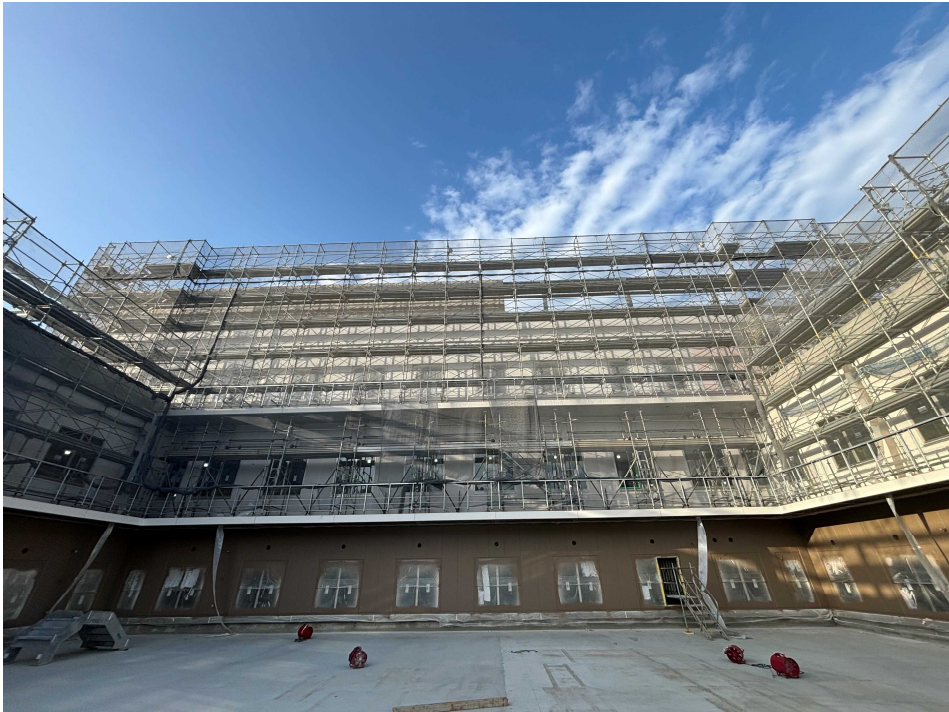
病院本棟 4 階(病棟階) 施工状況
