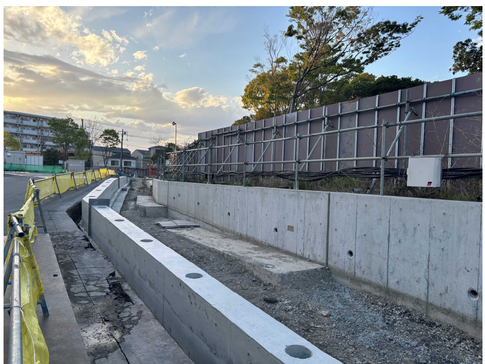
外構工事 施工状況
