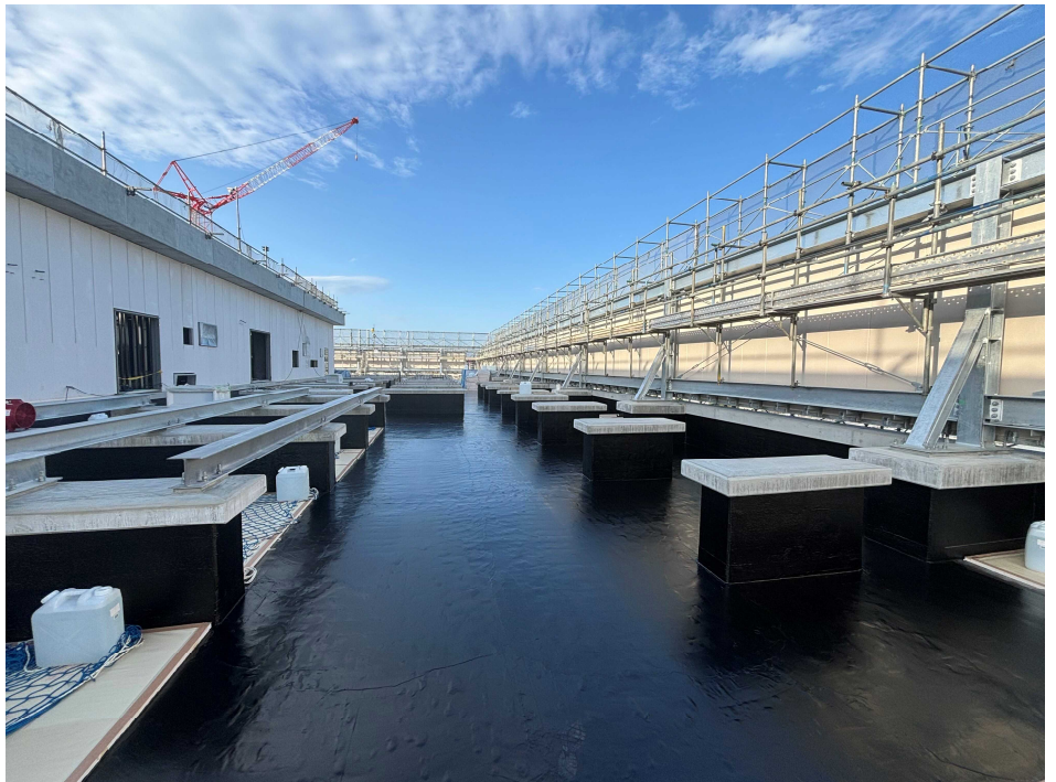
病院本棟 7 階 施工状況
