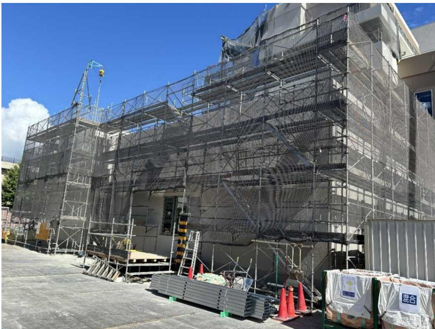
外壁塗装が完了した状態です。引き続き外壁面の樋、タラップ等の取り付けを行っていきます。内部は壁下地となる軽量鉄骨下地組みを施工しています。
