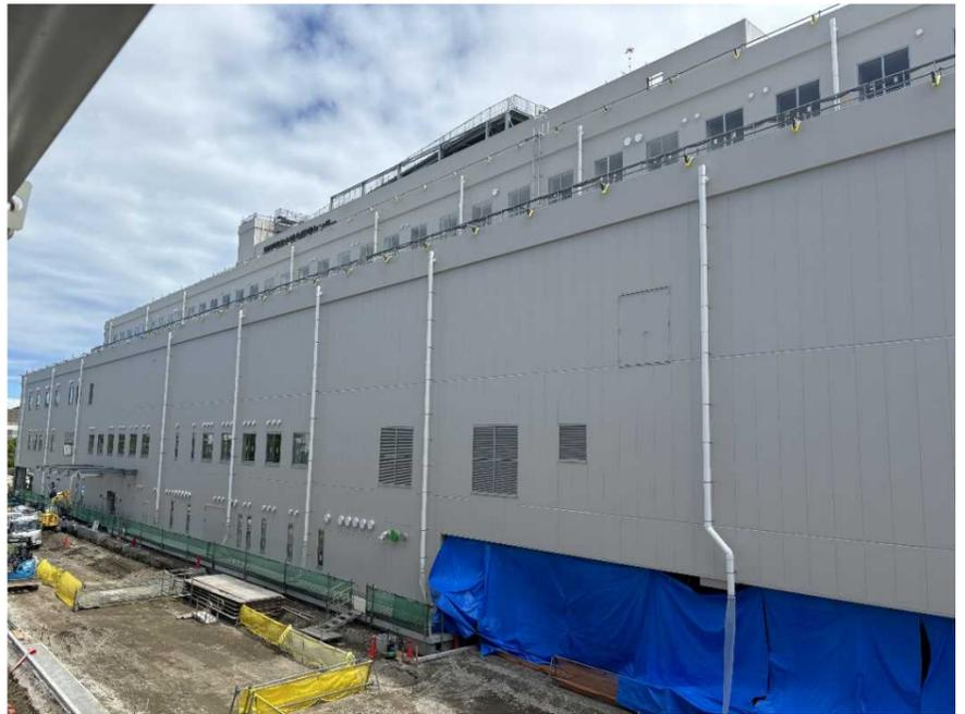
西面(神明小学校側)の足場解体後の状態です。7階外壁面に館銘板を設置しています。今後、救急車の停車場所に庇を取り付けます。
