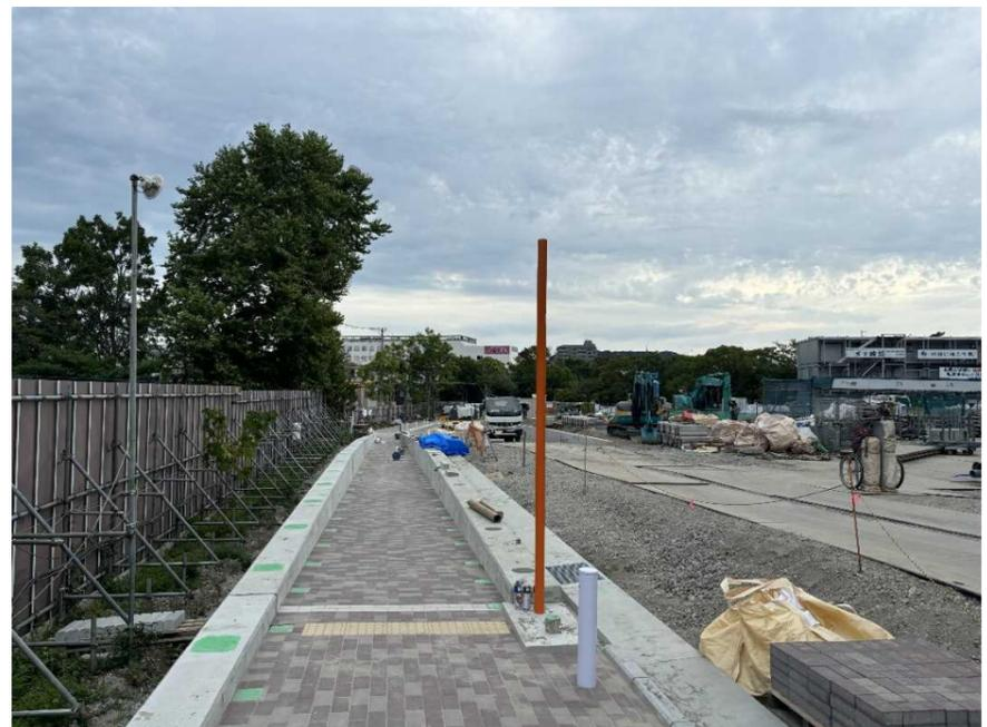
病院敷地内の歩行者通路の舗装(インターロッキング)工事が完了した状態です。傾斜路の始点・終点の色を変えたり、警告ブロック等を設置し、バリアフリーに配慮しています。今後、傾斜路に点字付き手すりを設置していきます。
