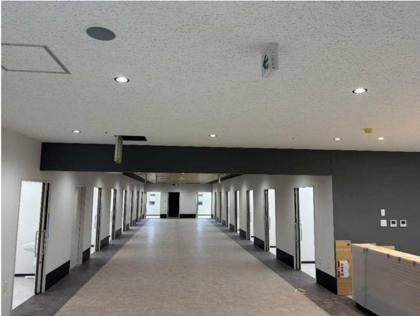
壁・天井の壁紙貼り、設備器具の取り付け、床のビニルシート貼りを行った状態です。建物内部もバリアフリーに配慮しており、今後、廊下に点字付き手すり等を設置していきます。
