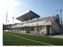
某公園管理棟新築工事
