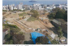
某公園リニューアル工事
