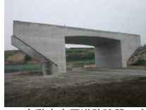
自動車専用道路建設工事
