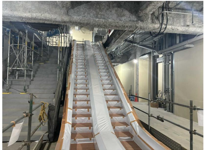
1階エントランスと2階外来受付を結ぶエスカレーターを設置しています。(白色のシートで養生しています。)今後、エレベーターも設置していきます。
