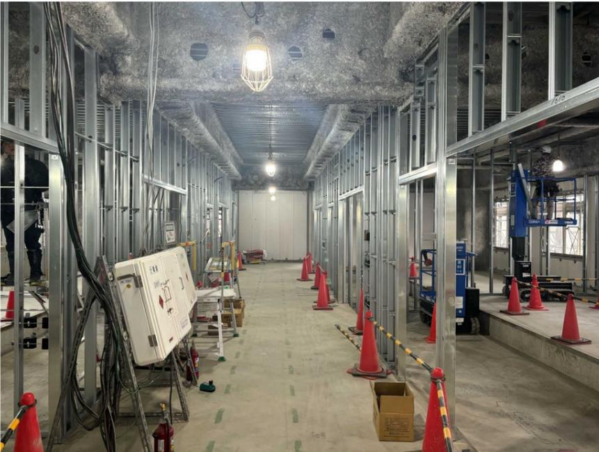
部屋を間仕切る壁の下地を施工しています。今後、壁のボード張りや天井下地を施工していきます。
