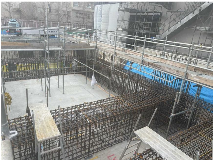
基礎躯体の鉄筋工事を行なっています。今後、型枠工事をを行いコンクリートを打設します。
