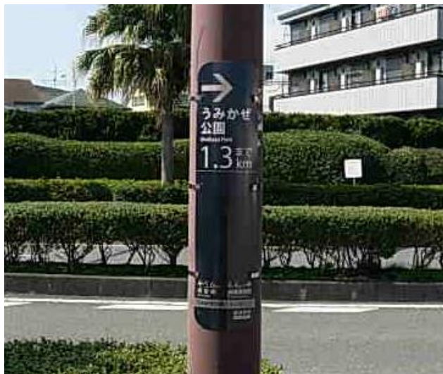
⑩海辺つり公園前・下り線（海側）照明灯No.3400
