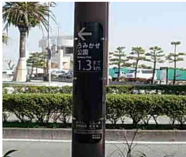
上り線（山側）照明灯 No.3401
