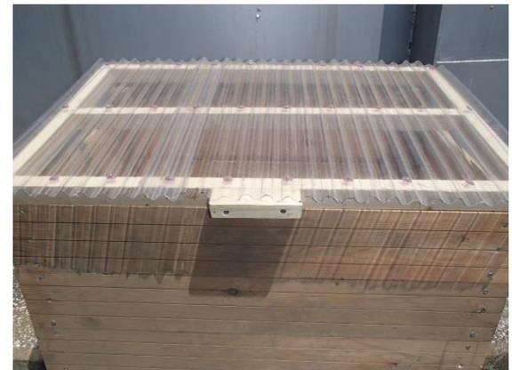
フタ用材料(1)角材④をネジで固定
