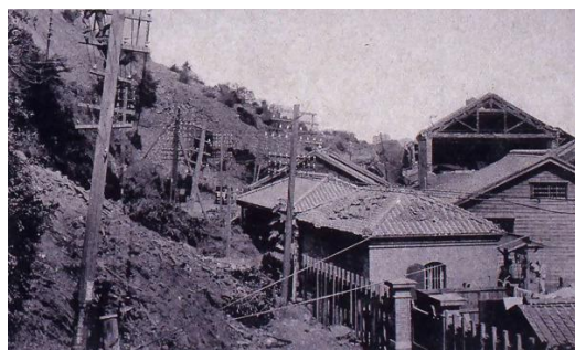
汐入駅～横須賀駅付近で発生したがけ崩れ。「横須賀大地震 道路ヲ埋メタル港町」絵はがき。横須賀市自然・人文博物館蔵。
