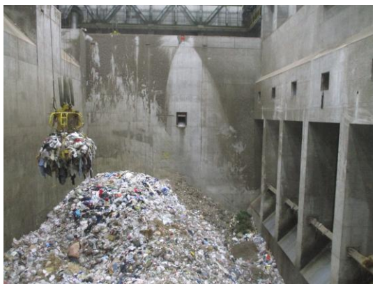
燃せるごみピット内の様子
