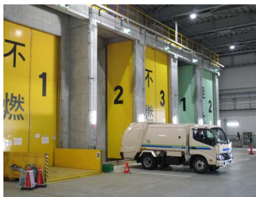
不燃ごみ等の投入ステージ
