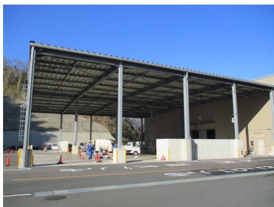
前処理ヤード
