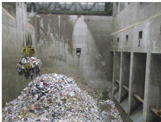
燃せるごみピット内の様子
