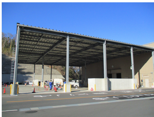
前処理ヤード
