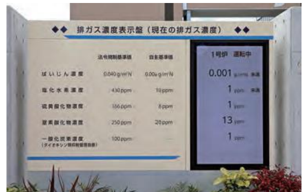
排出ガス濃度表示盤
