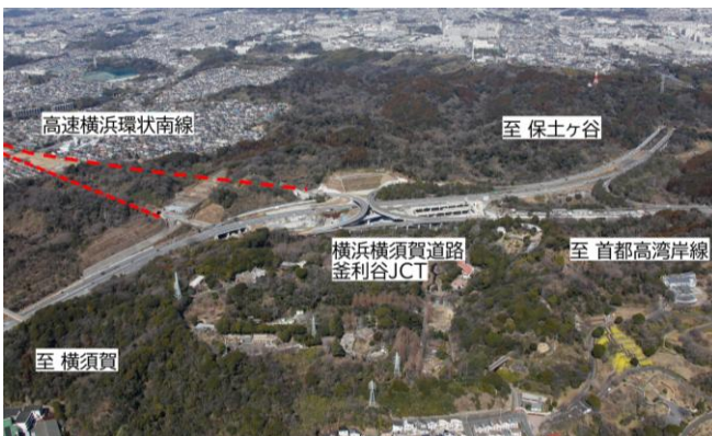
▲横浜横須賀道路の釜利谷ジャンクションから一般国道1号を結ぶ高速横浜環状南線事業が進められています
