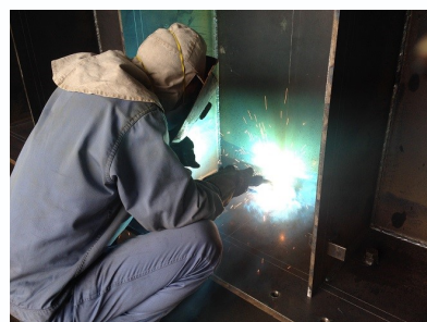
アルミ溶接状況
