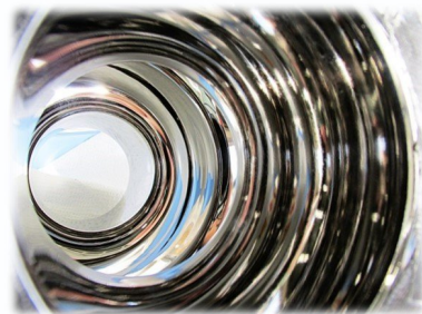
施工例（超高真空ダクト）
