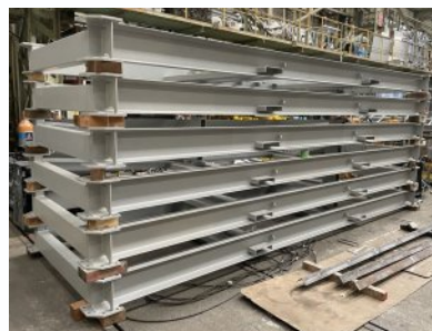
立体駐車場のパレット
