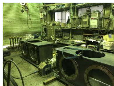
ダクト製缶中
