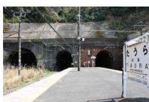
七釜・田浦トンネル
